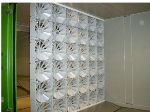
La présence d'impuretés et de dommages sur la cloison de modules vortex doit être contrôlée dans le cadre de la maintenance annuelle. Les éventuelles impuretés doivent être éliminées à l'aide d'un nettoyeur à base alcaline conforme aux dispositions de la norme VDI 6022.
