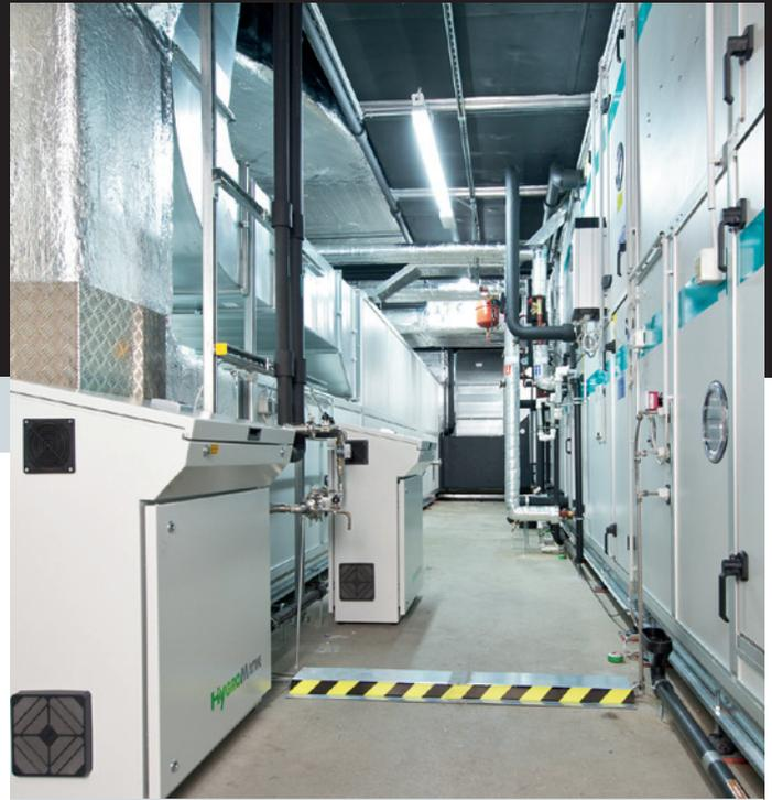
Der Technikraum der Blutzentrale Linz mit zwei HygroMatik HDS-Anlagen zur Luftbefeuchtung in den Klimazentralgeräten
